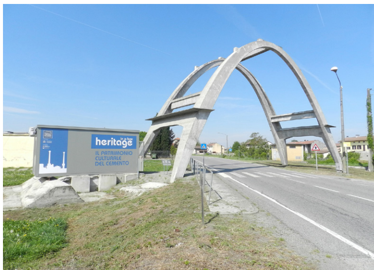
Fig. 5. Morano sul Po (Alessandria). Arco parabolico recentemente restaurato e il nuovo centro di documentazione realizzato nell’ambito del progetto Heritage in a box (foto M. Mattone 2023).
