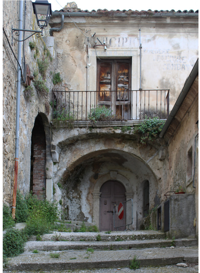
Fig. 2. Rocchetta Alta (IS). Edificio che ospitava il Municipio (foto M.P. Testa 2023).
