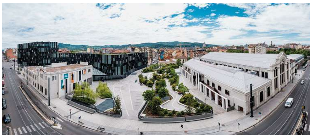
1: Panoramica dell'esterno della Centrale Nuvola Lavazza.
