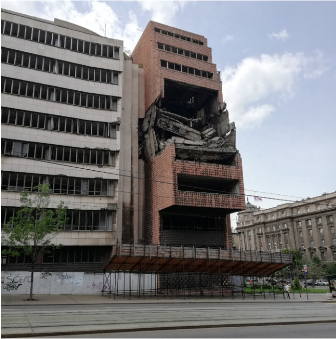
Fig. 2. Belgrado, Serbia. Zgrada Generalštaba . Conservazione materica dell'autenticità della rovina (foto E. Morezzi 2019).
