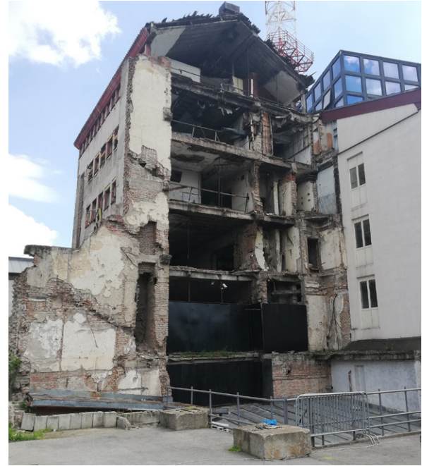
Fig. 3 Belgrado, Serbia. Sede della Radio e televisione serba. Rudere del bombardamento in attesa di un intervento (foto E. Morezzi 2019).
