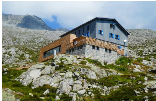
Figura 3. Ristrutturazione e ampliamento del rifugio Città di Trento al Mandrone, Livio Noldin, 2022.
