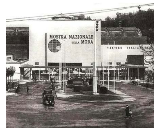
Fig. 3 - Facade of "Palazzo della Moda", picture b/n. (MAME, 2021).
