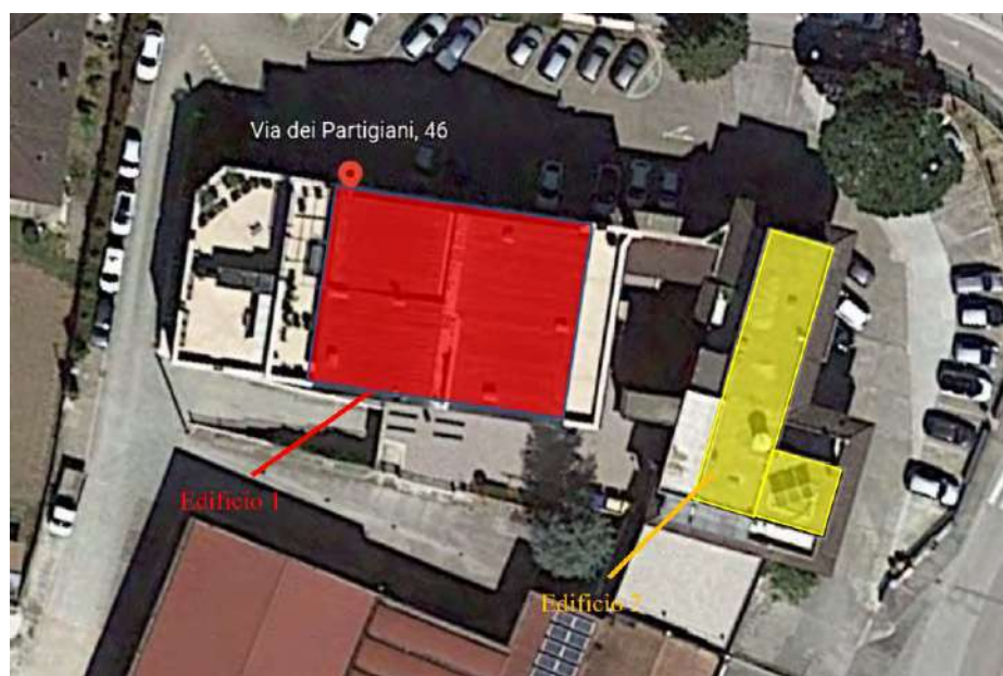
Figura 4. Immagine Satellitare degli edifici selezionati
