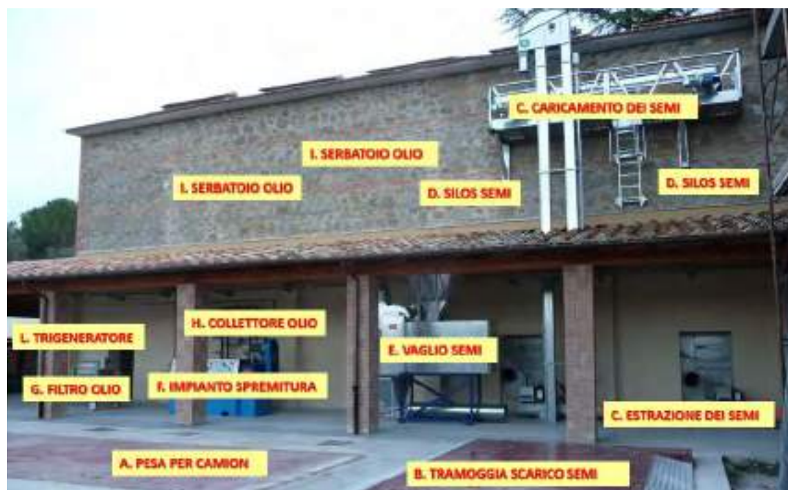
Figura 1. Impianto di S. Apollinare, prospetto dei componenti della filiera dei bioliquidi.
