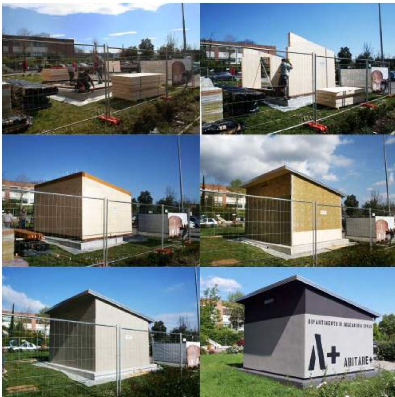
Figura 2. Varie fasi costruttive della test room.
