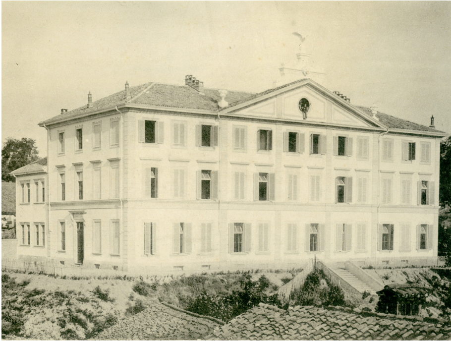
Fig. 6 _Edificio scolastico di Montà, realizzato su progetto di Camillo Riccio (MC_731).
