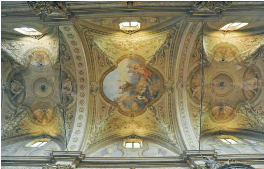
Fig. 11_Volta della navata centrale della chiesa di Sant'Antonio Abate, 2010 (foto di Dino Capodiferro). La rappresentazione riprende in parte i soggetti proposti nel bozzetto conservato in archivio (MC_702b).
