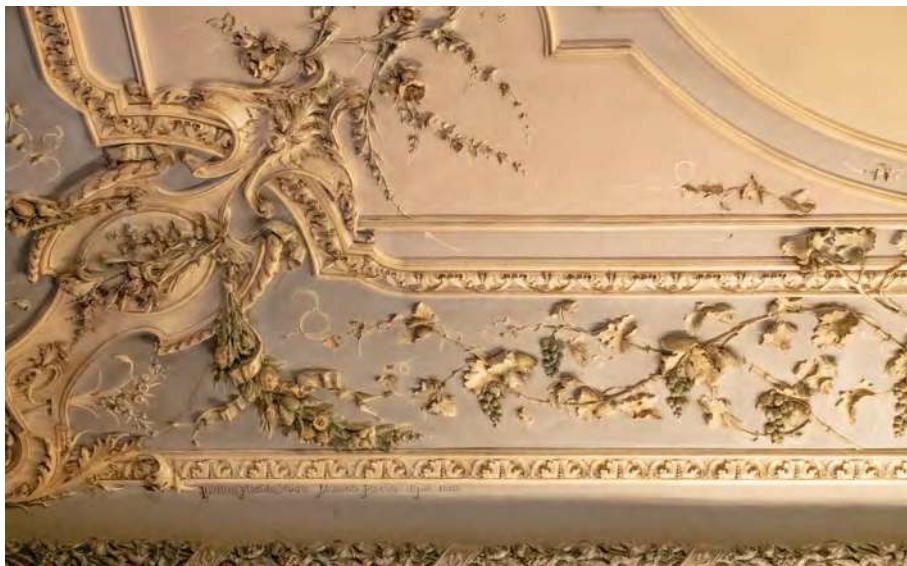
Fig. 15_Particolare della decorazione della volta della sala da pranzo di palazzo Corbetta Bellini di Lessolo, 2023. In basso a sinistra si legge la firma di Placido Mossello.
