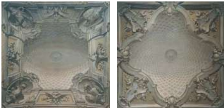
Fig. 6-7_Soffitti di due ambienti contigui al piano terra di villa Savoia Carignano, 2010 (foto di Dino Capodiferro).
