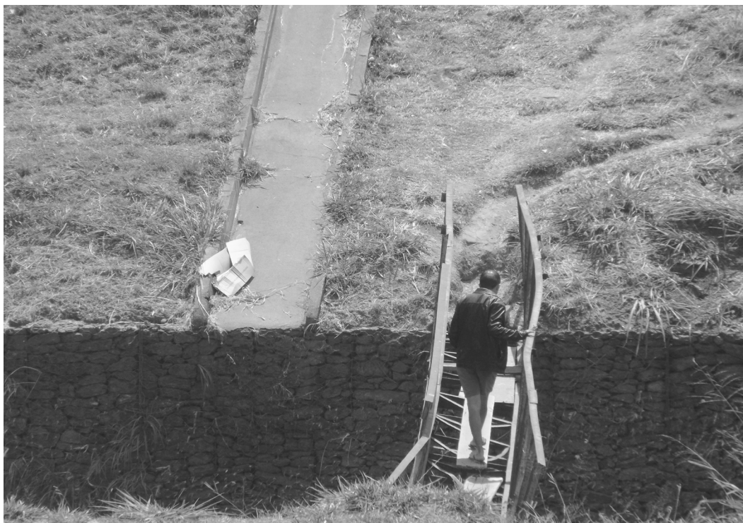
Figura 8 - Passagem improvisada de moradores entre a região da rua 44 e setor Criméia Leste. Fonte: Acervo do autor. 03/09/2017
