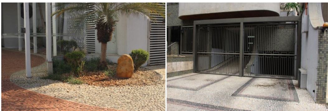
Figuras 15 e 16: Calçada portuguesa avançando para o interior dos edifícios. Foto: Roney Haarengl Moreira Braz, 2017
