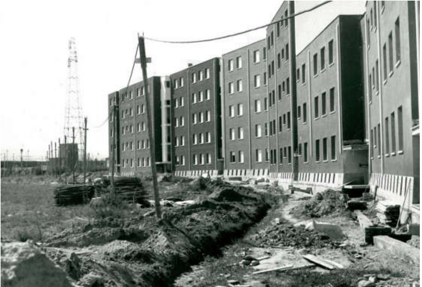
Fig. 6 Cantiere dell'edificio di Glauco Gresleri al Pilastrò, 1965. Archivio privato di Glauco Gresleri.
