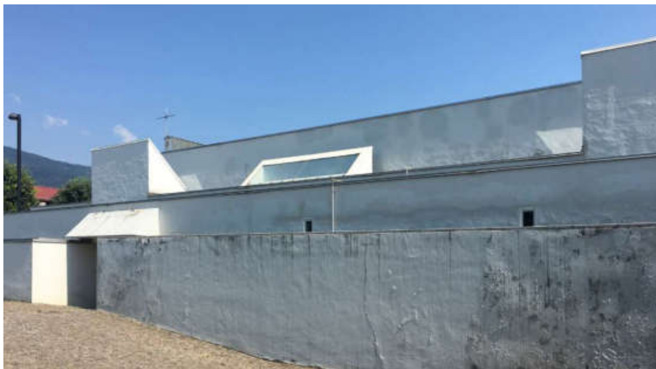
Fig. 7 Chiesa e opere parrocchiali di Vajont. Particolare del fronte ovest verso il percorso pedonale di accesso.
