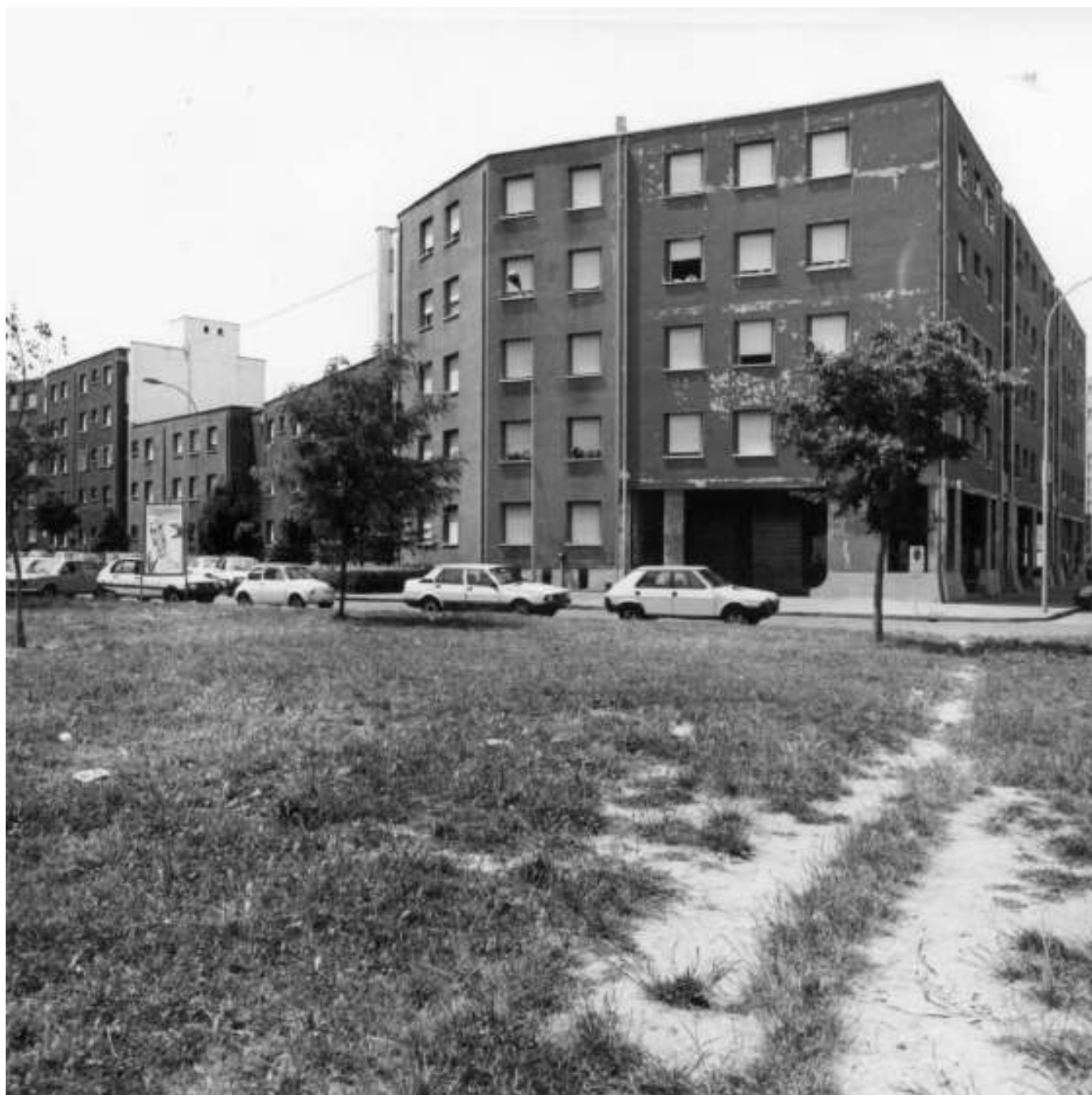
Fig. 8 Edificio di Glauco Gresleri al Pilastro, 1975. Archivio privato di Glauco Gresleri.
