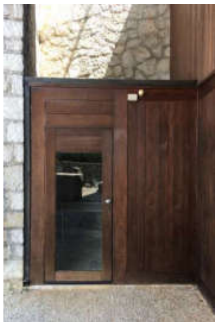
Fig. 4 Cimitero di Vajont. Particolare del tamponamento in legno e di un serramento della cappella.
