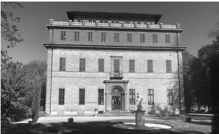
Fig. 8. Villa San Luigi a Chieri, fronte lato corte (foto A. Bocchiotti, 2023).
