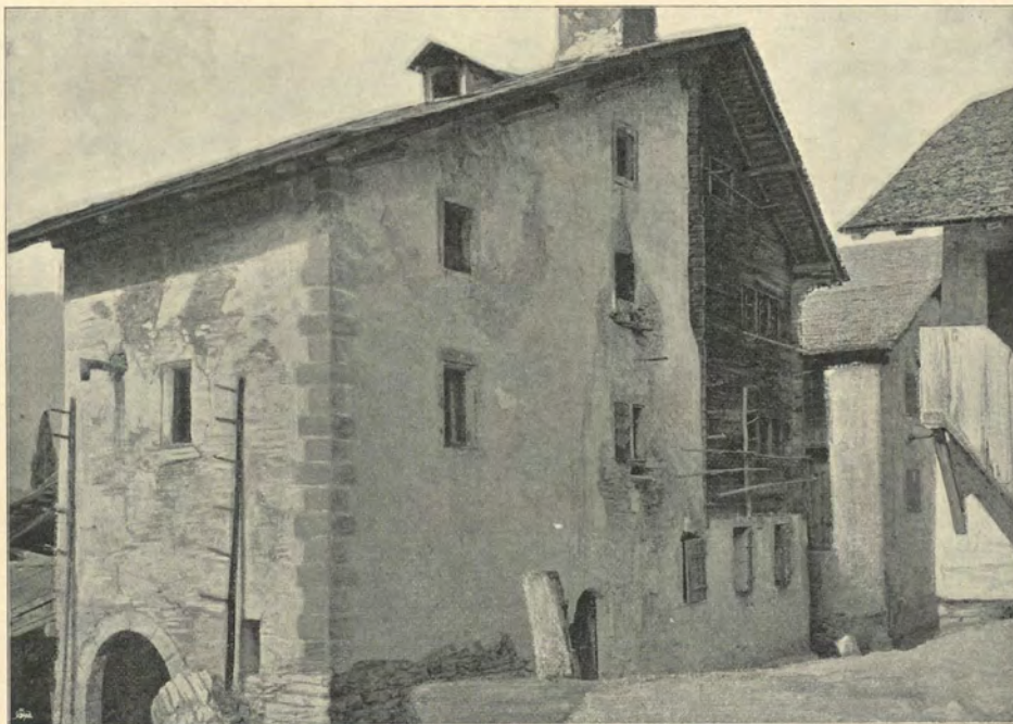
Fig. 71. Maison à Chaley.
