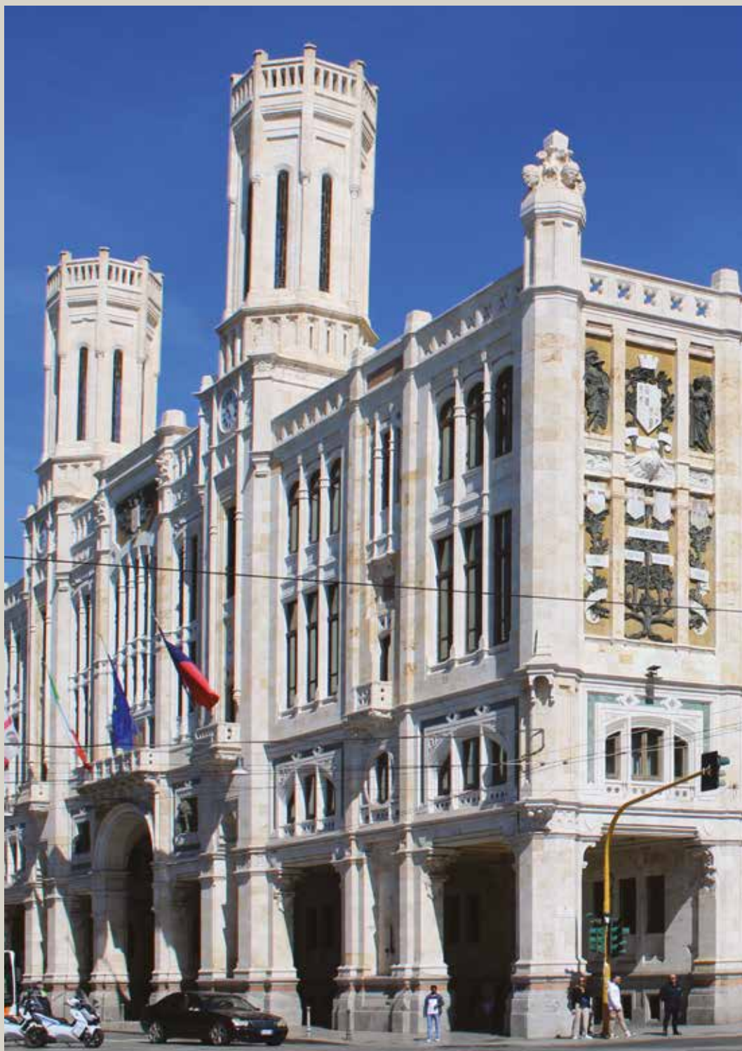
1. Cagliari. Palazzo Comunale: prospetto principale su via Roma e rigiro d'angolo su largo Carlo Felice. Foto dell'A., 2023.
