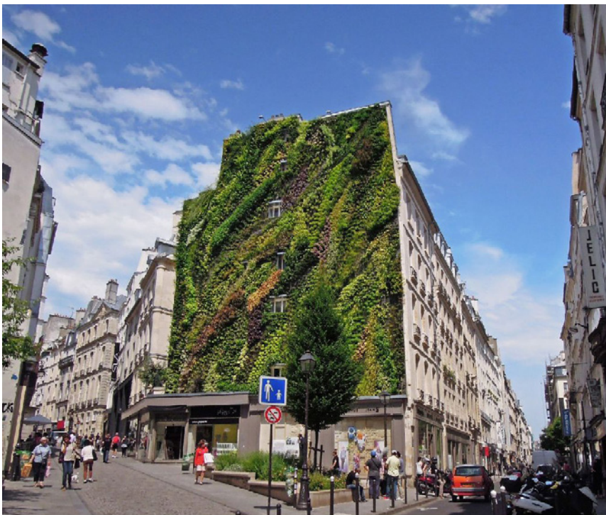
Fig. 1 Oasis D'Aboukir, Parigi, l'edificio prima dell'intervento di Patrick Blanc, 2013, fonte fotografia https://www.architetturaecosostenibile.it/
