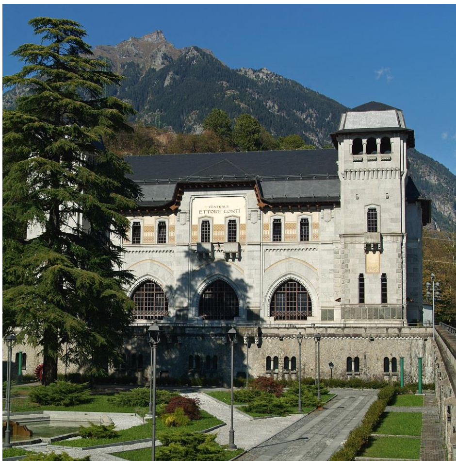
Figura 4. Centrale de Verampio (Italia). Proyecto de Piero Portaluppi, 1913. Foto Studio Publica, 2017.
