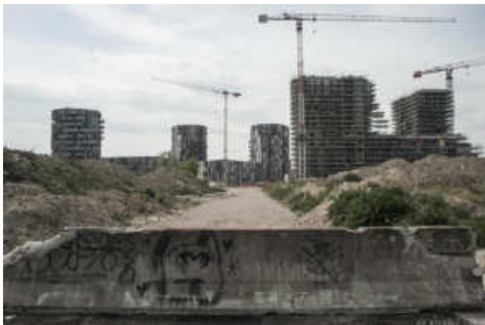
Fig. 8. Il cantiere di piazza Liber Paradisus.
