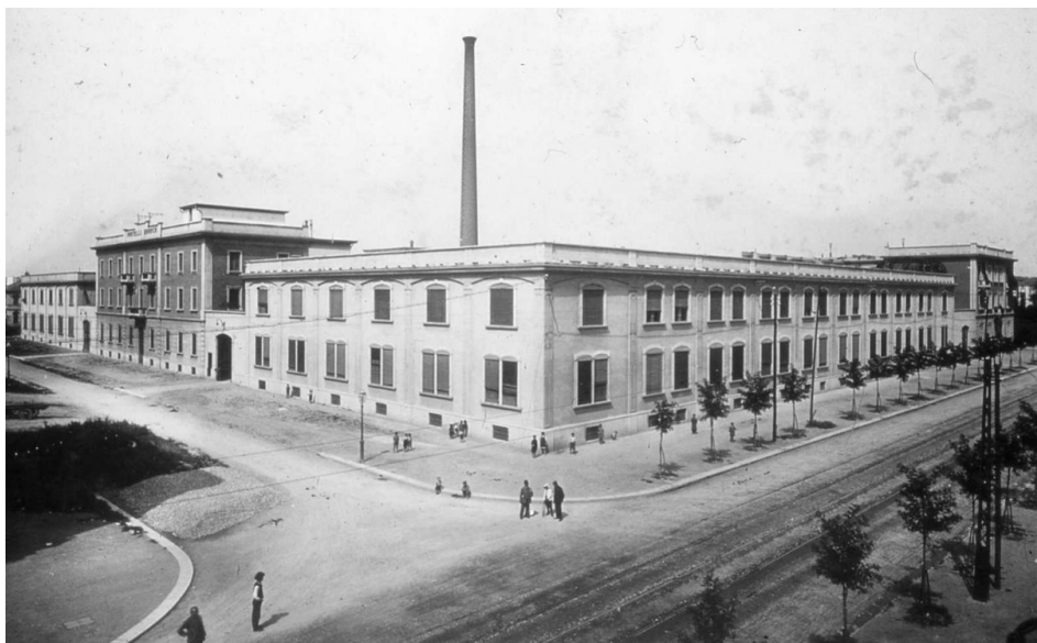
Fig. 1 — Lo stabilimento della Cge a Milano. Il fabbricato era prima appartenuto alla Aeg Thomson-Houston Società italiana di Elettricità S.A. costituita nel 1904.
