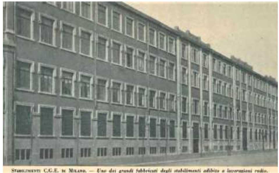
Fig. 2 — Cge di Milano, uno dei fabbricati adibiti alla produzione di apparecchi radiofonici
