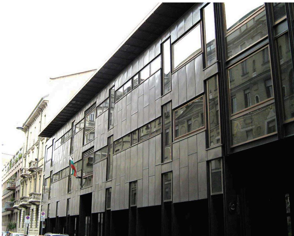
La façade de la Serenissima sur la via Cavaliere à Milan (Italie) avant l'intervention reflétant la Ca' Brutta.
