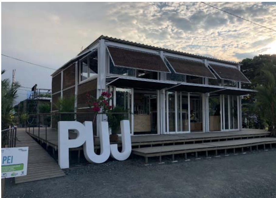
Figura 1.2.3 Immagine dell'edificio PEI Maquina Verde (Fonte: Lorenzo Savio).
