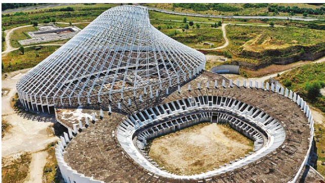
fig. 12 – Roma: la Città dello sport, commissionata dall'Università di Tor Vergata all'architetto Santiago Calatrava, e mai completata. Essa rappresenta un eccezionale caso di rovina che merita di essere tutelata, conservata e valorizzata anche solo come imponente rovina contemporanea.
