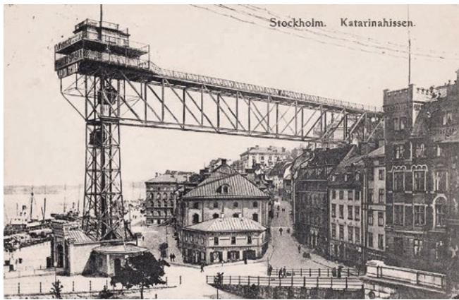
Il Katarinahissen di Stoccolma (1919) è un ascensore per passeggeri che collega le diverse altezze di Slussen e Södermalm. L'ascensore originale è stato costruito nel 1881.
