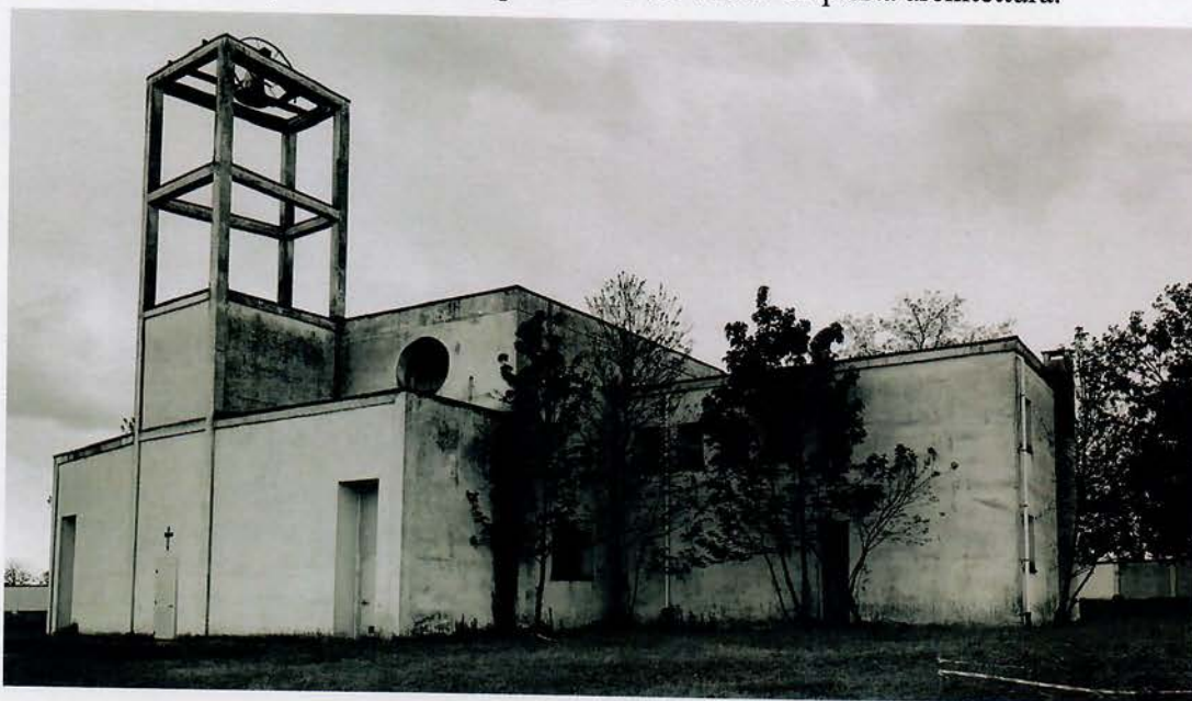
Figura 6. La cappella oggi (foto di Paolo Mellano).
