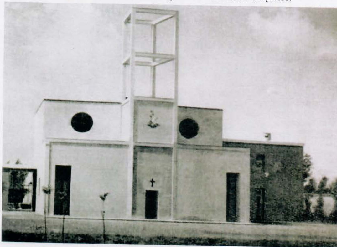
Figura 4. L'esterno e la struttura a traliccio del campanile (da "Alessandria", 1938).
