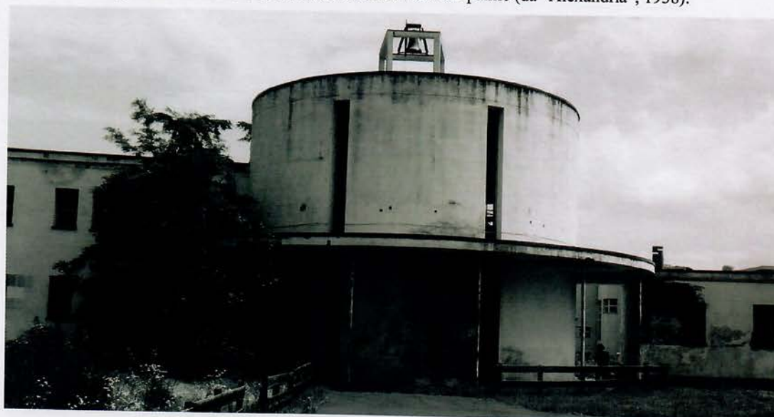
Figura 5. Il deambulatorio esterno (foto di David Vicario).
