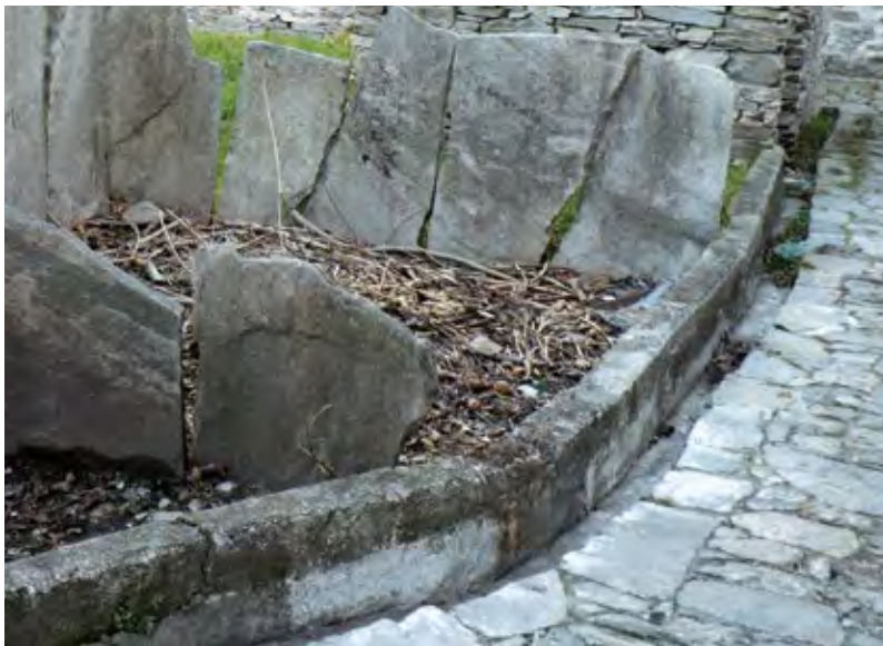
Figura 15 Selciato con cunetta di scolo delle acque a Roldo, Montecrestese, Valle Ossola.
