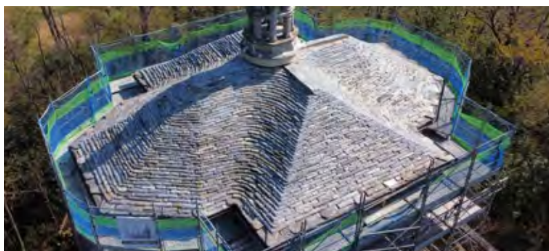
Figura 48 Impluvi ed espluvi in copertura polilobata. Cappella di Abramo - Sacro Monte di Ghiffa. Arch. Scotton.
