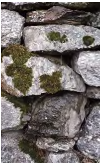
Figura 40 Muro a secco che drena (particolare): parete dello scannafosso a protezione della parete posteriore del pilone/altare di San Vincenzo Férrer, Via Crucis di Bannio, valle Anzasca, località San Vinzént, (prob. XVIII sec.)
