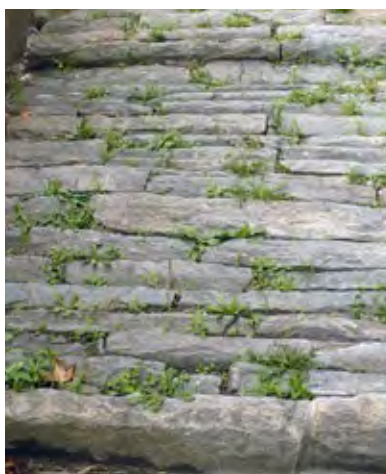
Figura 9 Selciato con piode di coltello (kurtlà), Beura, Valle Ossola.
