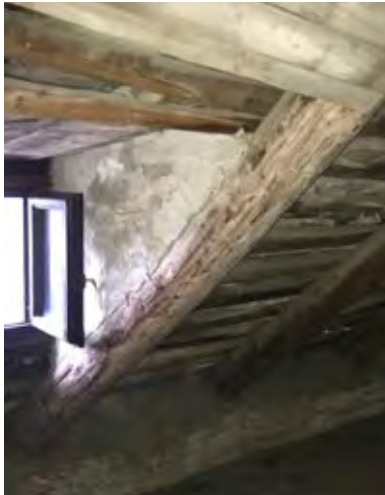
Figura 38 Abbaino. Dettaglio appoggio muratura su carpenteria.
