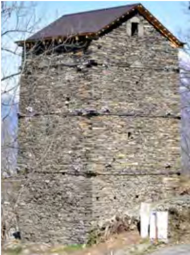
Figura 4 Torre dei Lossetti presso Beura Cardezza. Edificio di avvistamento (quindi a carattere difensivo) tra i più alti realizzati a secco fra quelli conosciuti in Europa (fotografia di G. Bretto).
