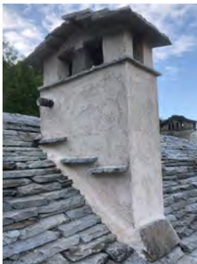
Figura 45 Camino in falda di nuova realizzazione.
