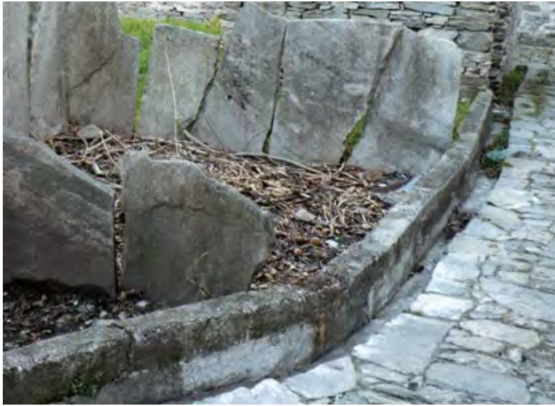
Figura 15 Selciato con cunetta di scolo delle acque a Roldo, Montecrestese, Valle Ossola.
