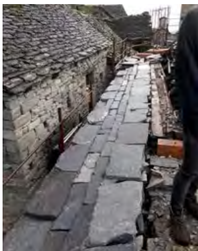
Figura 18 Aggetto di gronda. Piode di partenza e corsi superiori. Veglio - Montecrestese (VB). Arch. Scotton
