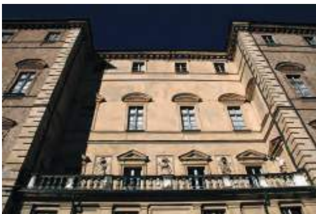
fig. 2 – Castello di Govone. Il fronte di levante, con affaccio sul giardino formale.
