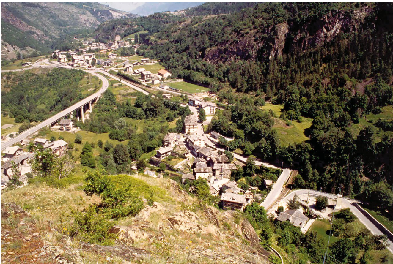
fig. 3 – Veduta del borgo di Leverogne (Arvier) dall’alto del santuario di Rochefort con in evidenza il rapporto dell’insediamento con la vecchia viabilità rispetto al nuovo viadotto della strada statale (fotografia dell’autore, 1996).
