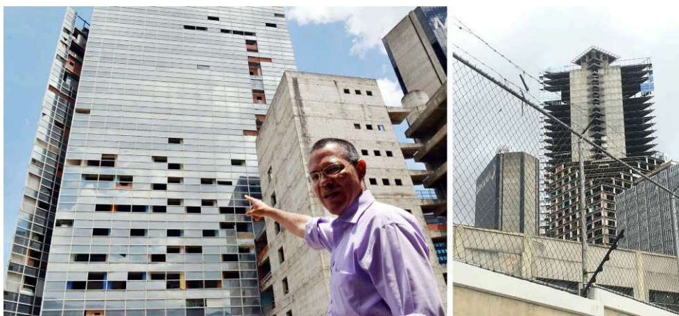
Figure 6. Façade en verre de la Torre David, avant et après
