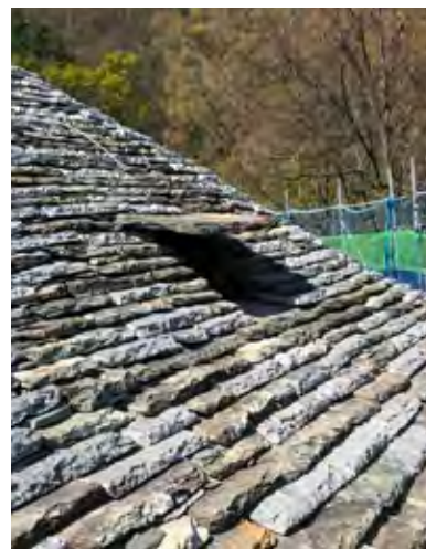
Figura 35 Vista laterale di un varco di passaggio per ispezione esterna del manto. Cappella di Abramo - Sacro Monte di Ghiffa. Arch. Scotton.
