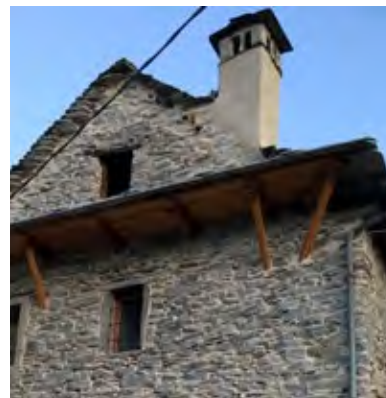
Figura 9 Gronda aggettante con saette. Trontano (VB). Arch. Scotton
