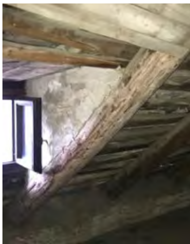
Figura 38 Abbaino. Dettaglio appoggio muratura su carpenteria.
