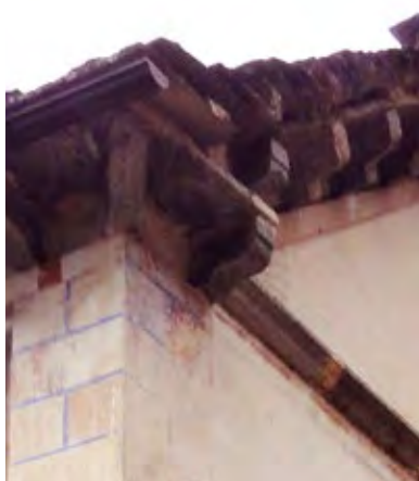
Figura 15 Gronda alla Romana. Oratorio Veglio - Montecrestese (VB)
