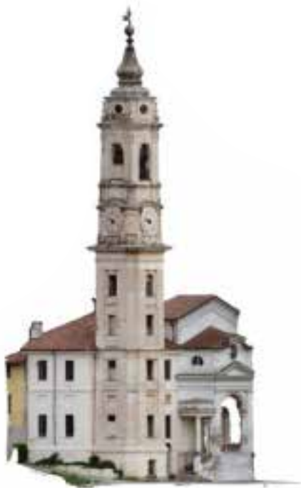
Figura 16. Montanaro. Campanile della ex casa comunale, scansione fronte sud (Laboratory of Geomatics for Cultural Heritage, Dipartimento Architettura e Design, Politecnico di Torino, 2020).
