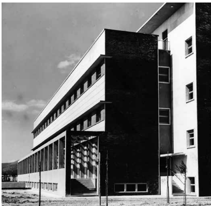
fig. 8 Ufficio tecnico Montecatini, colonia Montecatini a Cervia, 1939; fronte dell'edificio verso il mare (da "Costruzioni-Casabella", novembre 1941, n. 167).
