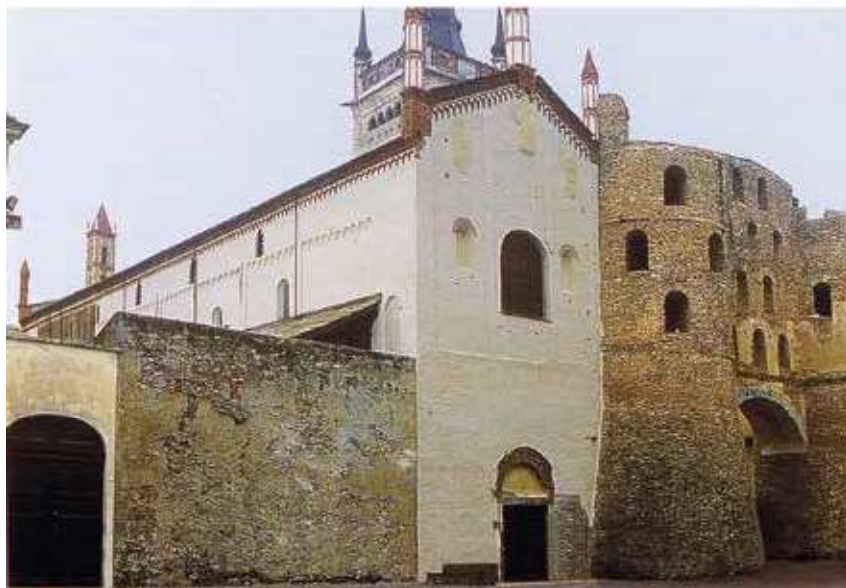
Fig. 3 - Susa, cattedrale di San Giusto, veduta occidentale, prima e dopo i restauri terminati nel 2005.
