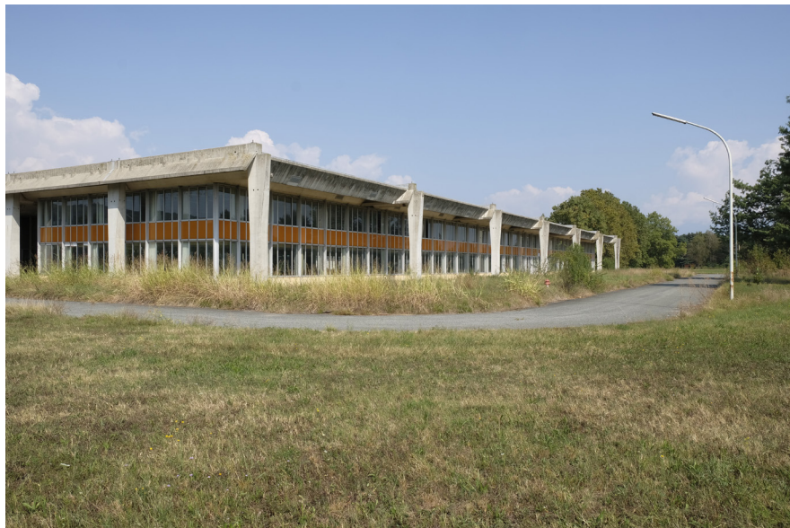
Fig. 3 | La fabbrica Olivetti di Scarmagno, l'edificio di Zanuso e Vittoria.
