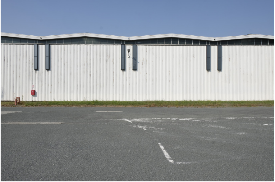
Fig. 4 | La fabbrica Olivetti di Scarmagno, capannone ancora utilizzato come deposito.
