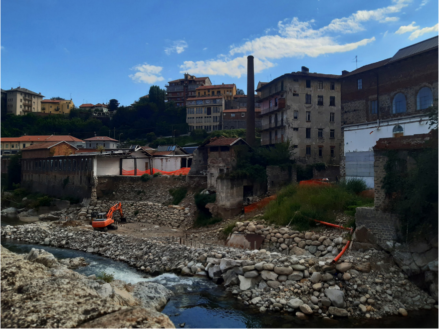
Fig. 3 | Lavori di ripristino dell'argine della Fondazione Pistoletto Cittadellarte.
