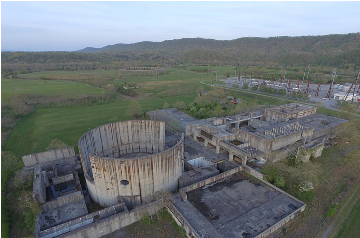
Fig. 2. Tennessee Valley, Phipps Bend Nuclear Power Plant Spring 2016, veduta aerea delle macerie della stazione nucleare abbandonata (foto di R. Clifton – licenza Creative Commons 4.0 International).
