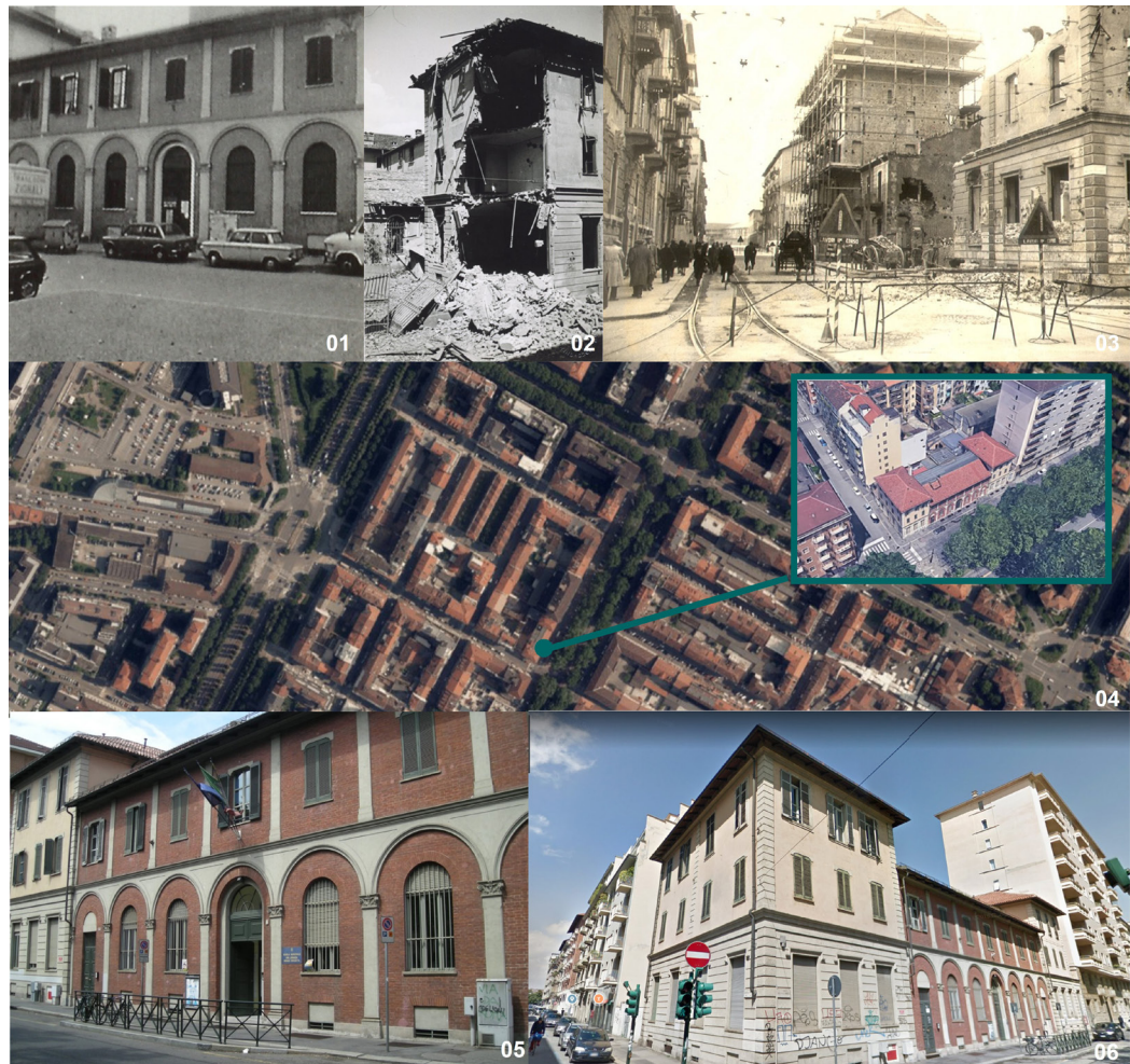
Fig. 03. Alcune immagini della Scuola Materna di Borgo Crocetta: 01 02 e 03 Immagini storiche: 01. Fronte principale della scuola, su Corso Duca degli Abruzzi; 02. Volume su Via Cristoforo Colombo angolo Corso Duca degli Abruzzi, crollo degli edifici, a causa dei bombardamenti aerei del 4 giugno 1944. UPA 4609_9E06_48. ASCT; 03. Ricostruzione Asilo Infantile Corso Cristoforo Colombo. ASCT, fondo Gazzetta del Popolo I 1369/A. ASCT. ( https://www.museotorino.it/view/e088ee8d15884e6faa-139aff470a739c ). 04. Vista aerea ( https://www.google.it/maps/ ). Immagini attuali della Scuola: 05. Fronte principale della scuola, su Corso Duca degli Abruzzi; 06. Fronte ad angolo Via Cristoforo Colombo angolo Corso Duca degli Abruzzi.
