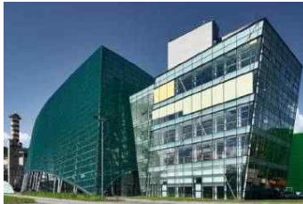
Impianto di Termovalorizzazione, Bolzano
