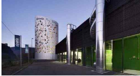
Centrale di teleriscaldamento Alperia, Quartiere Casanova
