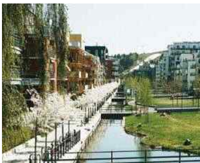
Canali d'acqua piovana
