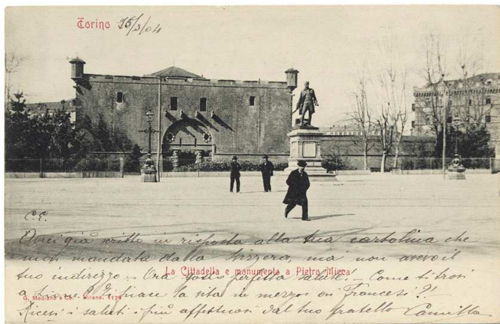
Fig. 5. Cartolina storica illustrante il donjon d'ingresso della cittadella di Torino, dopo la sistemazione a "decoroso fondale" della statua di Pietro Micca (ASCT, Nuove acquisizioni, cart. 670).
