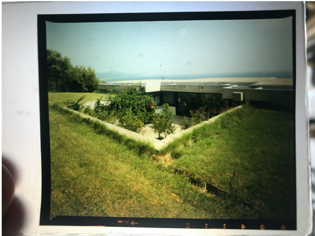
189. Il patio al livello superiore. Fotografia scattata da monte. Lo spazio verrà coperto e trasformato in studiolo. Autore e data non note. Negativo fotografico reperito presso lo studio di Marco Del Francia, agosto 2019, [MDF_DS_02_04_f07].
