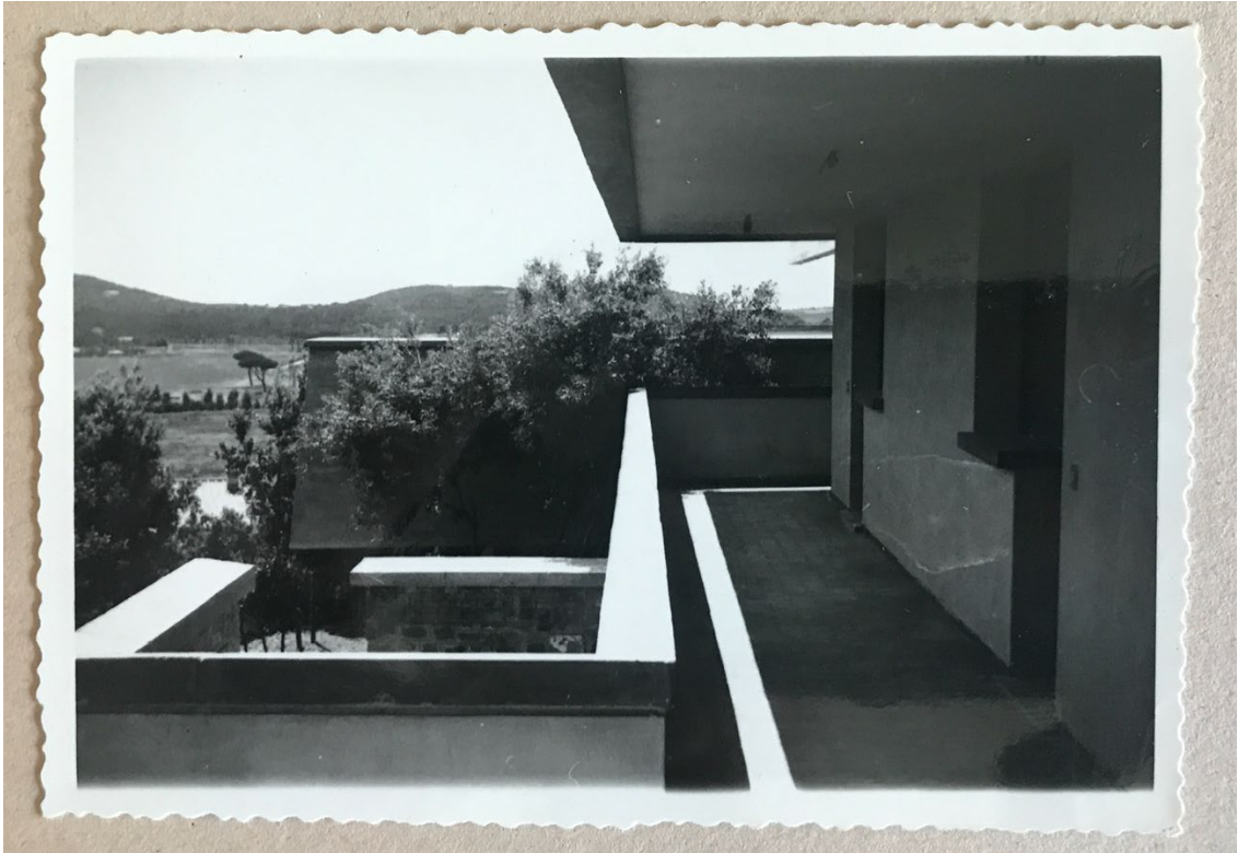
203. Vista dalla terrazza verso il mare, Villa Passani, Walter Di Salvo, 1963. Fotografia dell'architetto, reperita presso lo studio di Marco Del Francia, agosto 2019, [MDF_DS_02_08_01].
