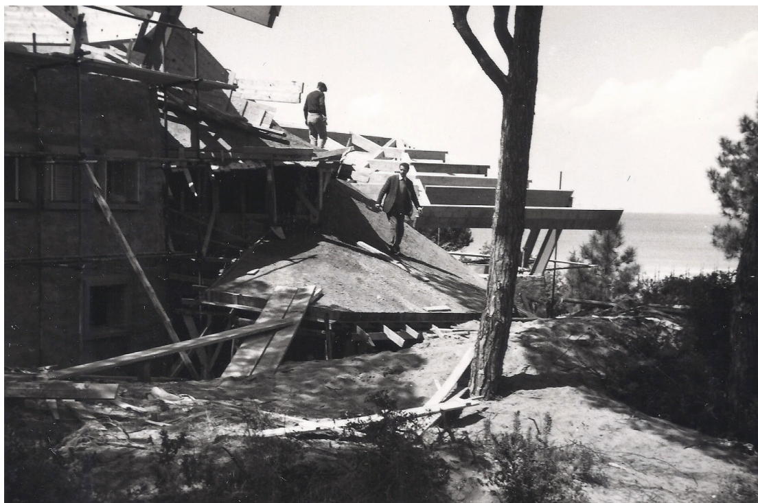
86. La Bussola, foto di cantiere di Walter Di Salvo, 1964. Materiale consultato presso lo studio professionale di Marco Del Francia, Comune di Follonica, agosto 2019. [MDF_DS_01_f03_001_03].
