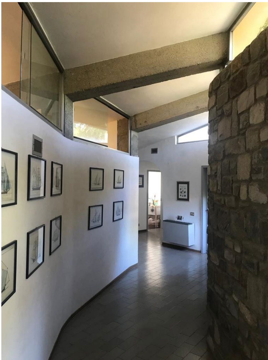
290. Il corridoio. Pavimentazione in ceramica grigia e contrasto materico tra la parete bianca interna e il muro esterno in pietra a vista; (agosto 2019).
