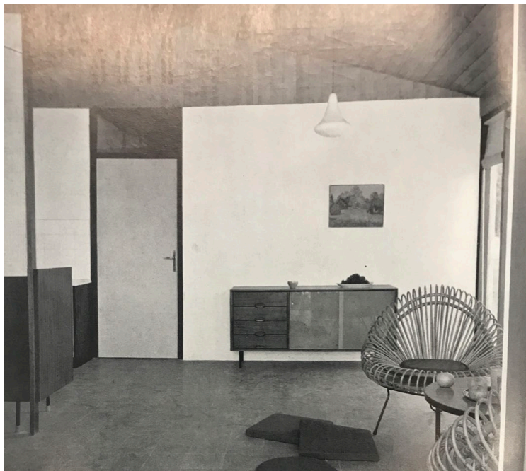
36. La controsoffittatura in larice del pranzo-soggiorno segue la pendenza della copertura ed è isolata da questa con un materassino di lana di roccia. Il pavimento del soggiorno è in piastrelle di graniglia color rosso-viola e i telai delle finestre sono dipinti di bianco su cassa blu. Fonte: Nella pineta di Lignano, in "Domus", n. 349, 1958, p. 40 (D-349-1958-PP37-40).
