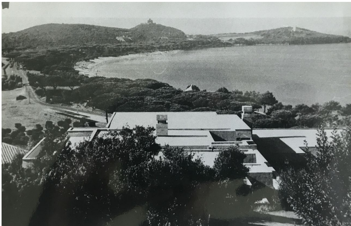
204. Vista da monte verso il mare, Villa Passani, Walter Di Salvo, 1963. Fotografia dell'architetto, reperita presso lo studio di Marco Del Francia, agosto 2019, [MDF_DS_02_08_02].
