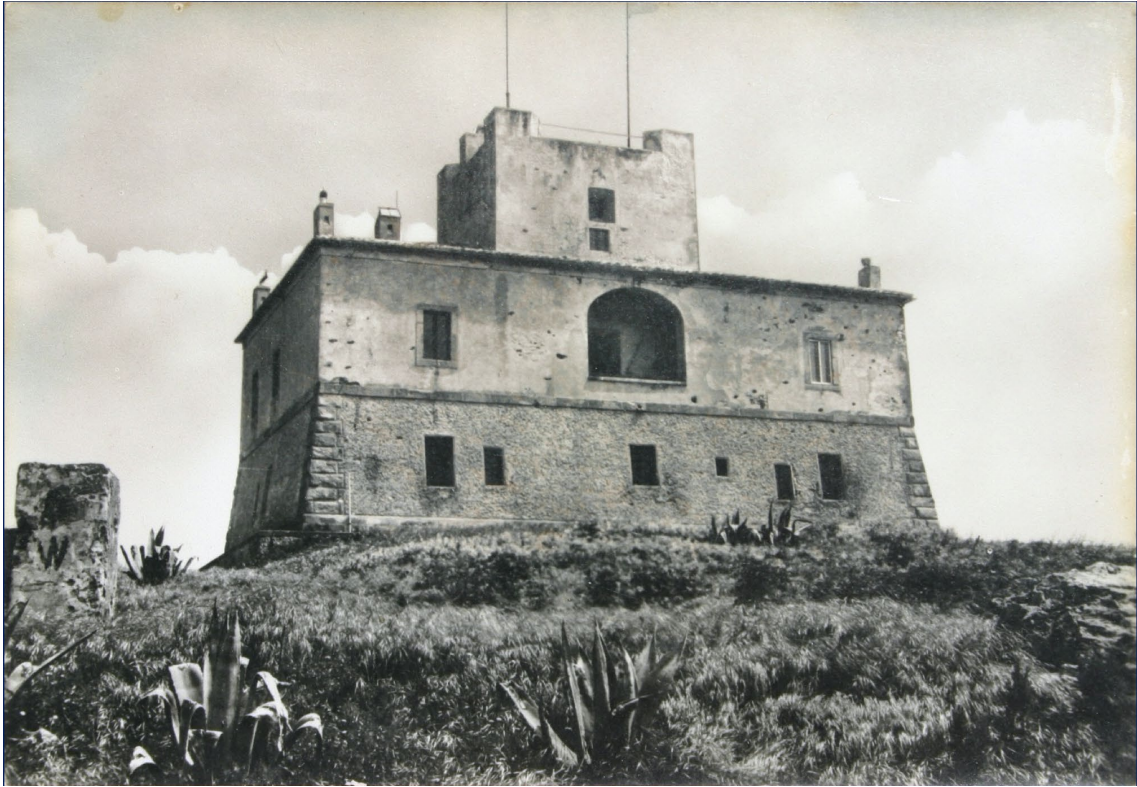
78. Il Castello di Punta Ala, anni Sessanta. Fotografia reperita nell'Archivio privato della sig.ra Cinzia Toppi - segretaria dell'architetto Francesco Paolo Piemontese dal 1968 -, il 20 agosto 2020 [CT_FP_oo_02].
