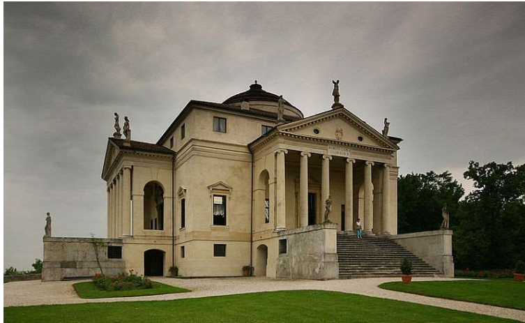
Fig. 7– Palladio, «La Rotonda», vista gnerale
