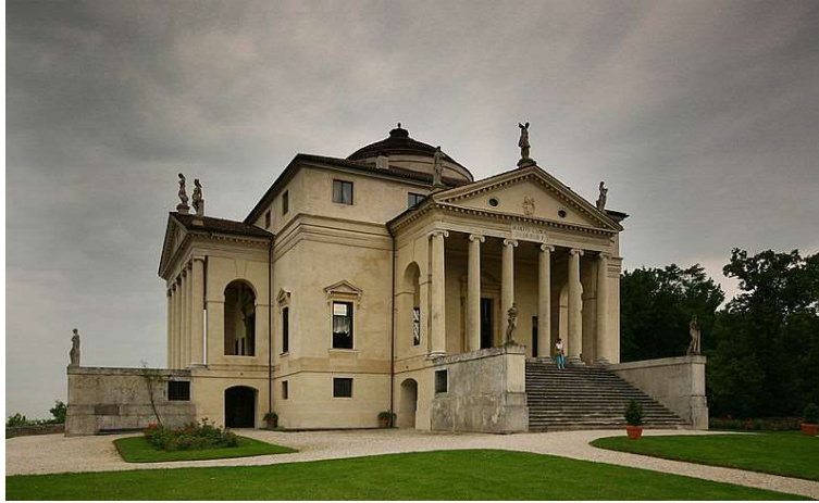
Fig. 7– Palladio, «La Rotonda», vista gnerale
