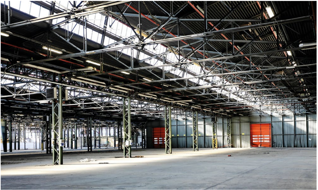
Figura 3. Vista interna dell'edificio industriale ex DAI a Mirafiori di proprietà di Torino Nuova Economia oggetto di riqualificazione (foto di Michele D'Ottavio).
