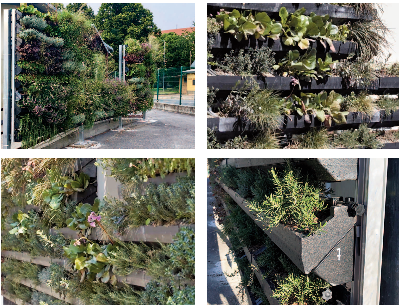
Figg. 5-8 | Images of the green wall (credit: Comune di Torino, 2021).
