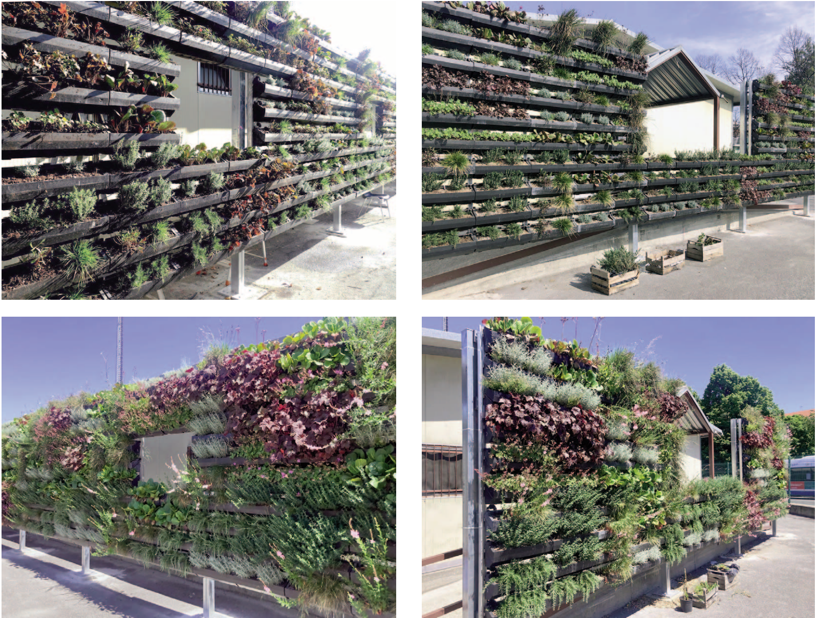
Figg. 1-4 | Images of the green wall (credit: Comune di Torino, 2021).
