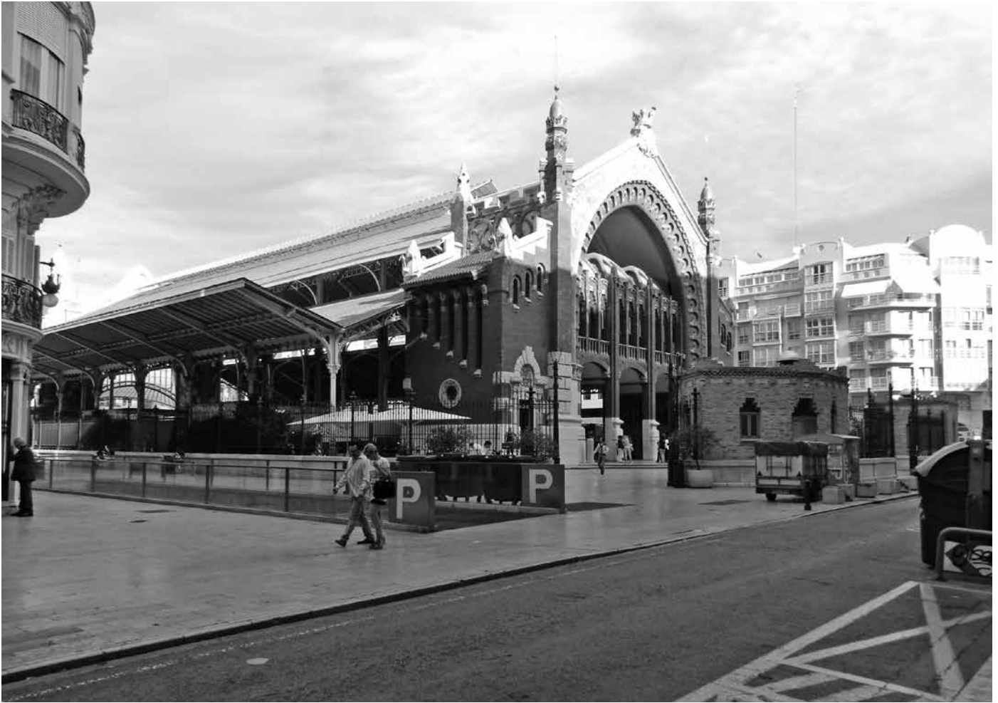
1. Valencia (Spagna). Mercado de Colón. L'intervento realizzato nei primi anni Duemila ha previsto un attento restauro delle strutture e degli apparati decorativi e il recupero dello spazio coperto per attività commerciali e culturali (foto Manuela Mattone, 2017).
