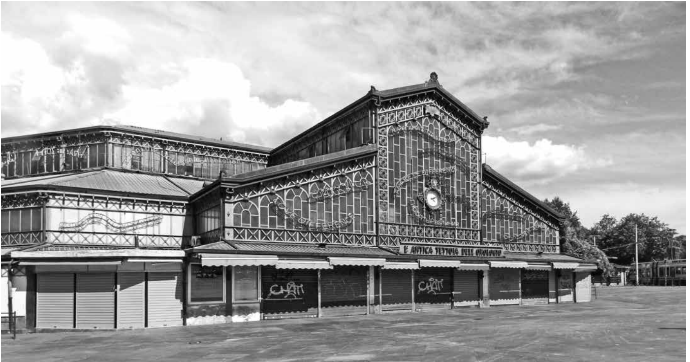
7. Torino. Porta Palazzo, tettoia metallica (1915), ingresso principale (foto Manuela Mattone, 2021).
