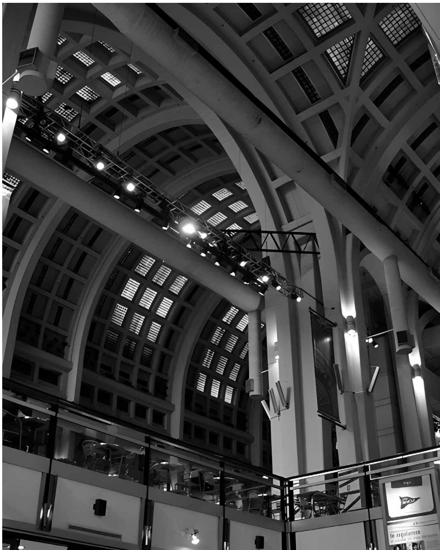
2. Buenos Aires (Argentina), Mercado Abasto Proveedor. L'intervento di rifunionalizzazione ha purtroppo comportato la frammentazione del volume interno, oggi non più pienamente percepibile, e la demolizione di parte delle strutture voltate (foto Manuela Mattone, 2007).
