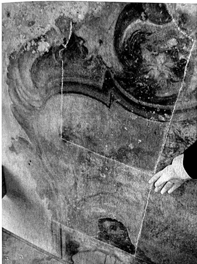
IMMAGINE 6. Prima arcata Est del narcece. Saggi di pulitura e di preconsolidamento dei dipinti murali.
