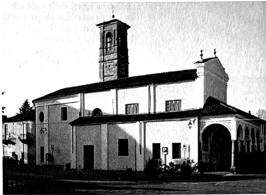
IMMAGINE 2. La chiesa ripresa da est dopo i restauri esterni. Si nota la differenza tra il tratto senza cornicione e la parte verso l'abside con il cornicione (ampliamento barocco).
