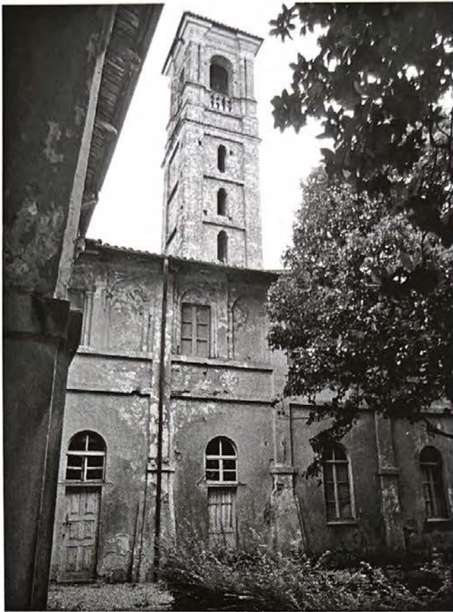
FIG. 10. Manica del chiostro verso la chiesa con gli archi tamponati.
