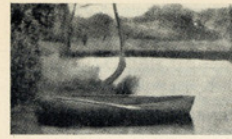
J. L. Lambot - Barca in calcestruzzo armato nel lago di Bourget (Illustr. tratta da «Cent Ans da B. A. s.»).
