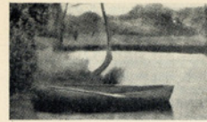
J. L. Lambot - Barca in calcestruzzo armato nel lago di Bourget (Illustr. tratta da «Cent Ans da B. A. s.»).
