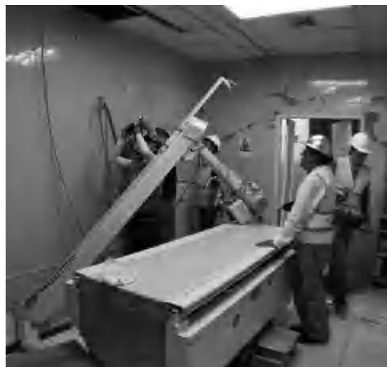
Foto 2. Hospital IESS de Manta internamente. Fuente: autores
