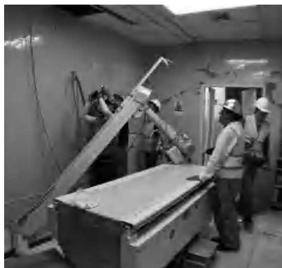
Foto 2. Hospital IESS de Manta internamente. Fuente: autores
