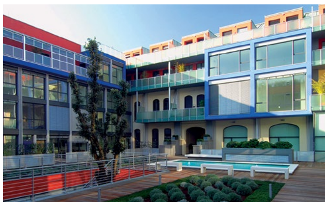
Edificio in via Aosta 8, già fabbrica Gilardini poi Tobler (1907–1972)
