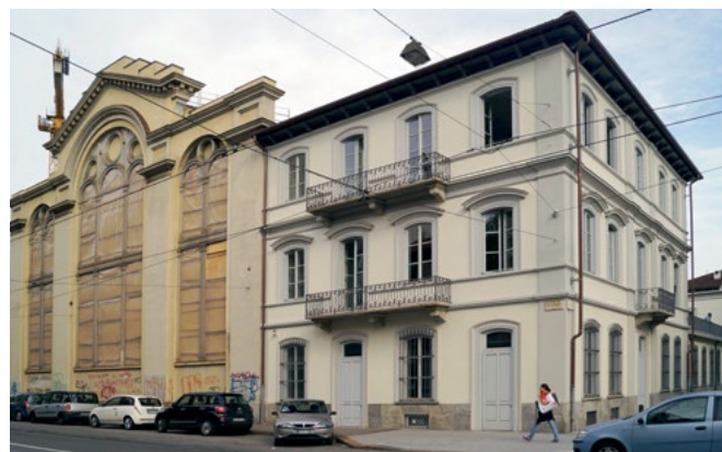
Sede Lavazza e Centrale Elettrica Enel, già SAEAI (anni 1891–1980)
