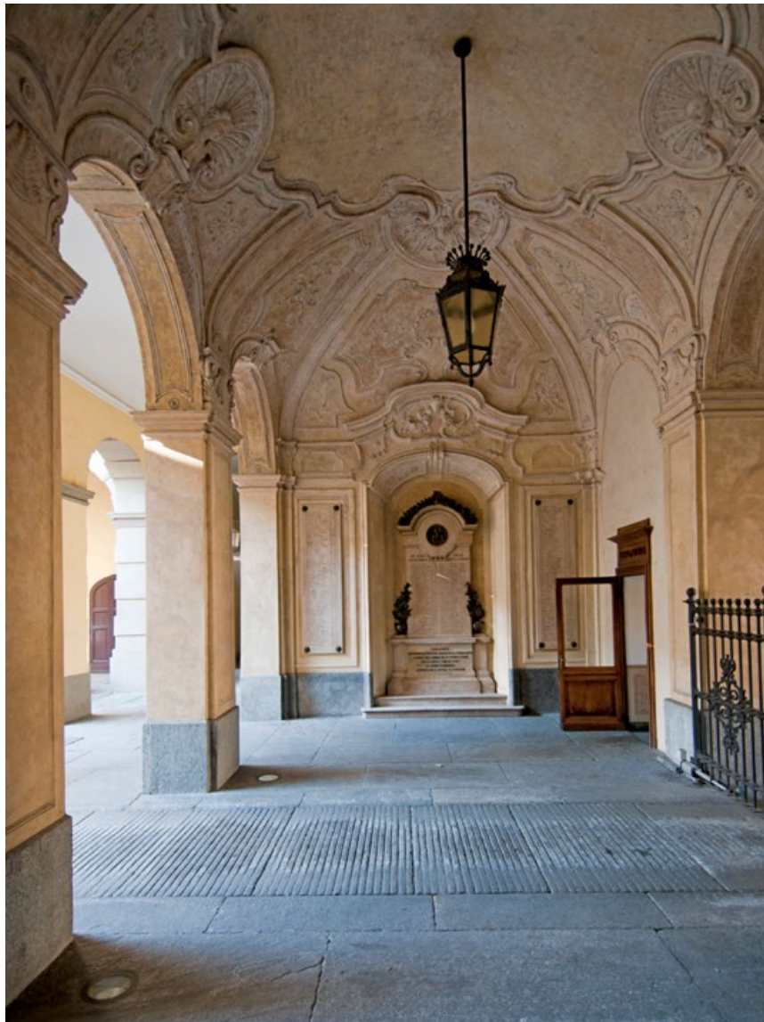
Figura 13. Torino. Collegio delle Province, atrio di ingresso dopo il restauro (foto di Consorzio San Luca, 2009).
