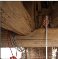
Fig. 3.2. Dettaglio delle travi incrociate su cui poggia l'elemento ligneo centrale della struttura della guglia
