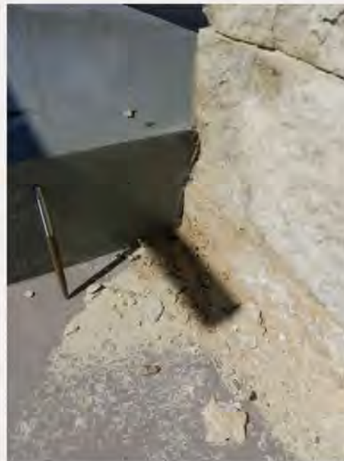
Foto 2-3: sinistra: profonda disgregazione di un calcare installato su rivestimento parietale. I fenomeni intensi e ad evoluzione particolarmente rapida (l'immagine di destra è stata scattata tre mesi dopo quella di sinistra) sono dovuti sia alla struttura fortemente porosa del calcare, sia all'aggressività dell'atmosfera salina, sia alle frequenti alternanze gelo-disgelo. Pitgrudy (Scozia)
