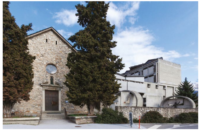
fig. 5 – L'ingresso alla Chiesa dei Cappuccini in rapporto all'ampliamento realizzato da Ravanne ( www.bourgeoisie-de-sion.ch ).
